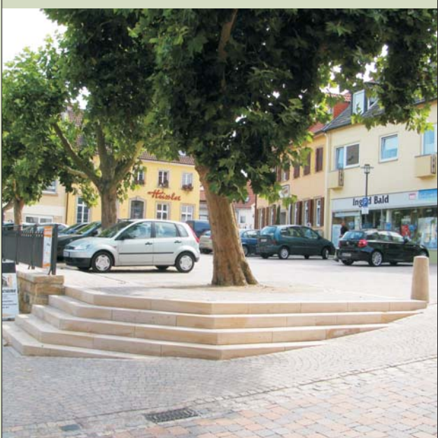
Öffnung und Erneuerung des Obermarktes
