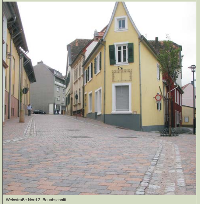
Weinstraße Nord 2. Bauabschnitt
