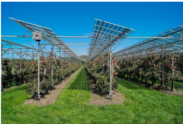
Abb. 6 Lichtdurchlässige PV-Module für den Obstanbau 16
