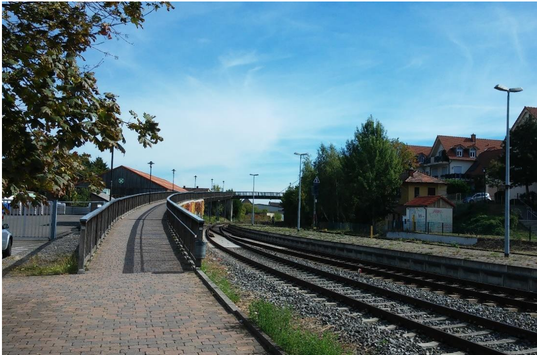
Abbildung 25 Fußgängerbrücke über Gleise am Bahnhof zur Anbindung des Fronhofs
